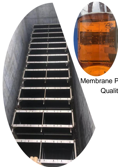
Membrane module installation
